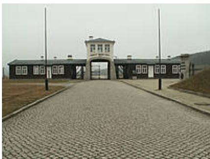
Brama główna wykonana została z miejscowego granitu./ Das aus dem örtlichen Granit eingebaute Haupttor.
