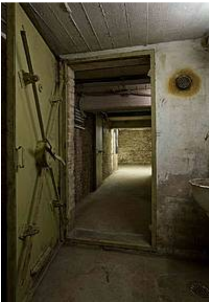
Blick in den Hausbunker der Gestapo im Tiefkeller / Bunkier w budynku
